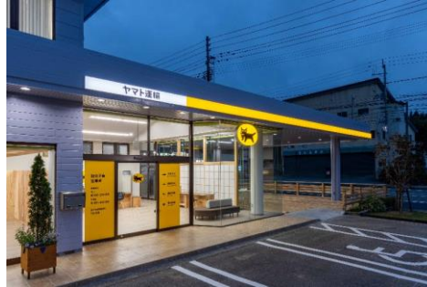
LED電球を設置した津南営業所（新潟県中魚沼郡）
