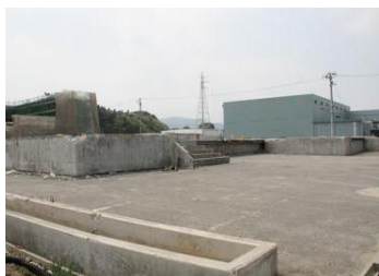
（組合の建物は基礎だけが残る）
