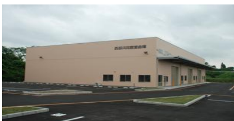
完成した西部共同農業倉庫
