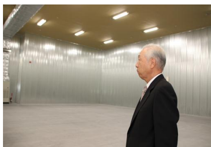
倉庫内を視察する有富理事長。二分割された倉庫は、米の在庫量が少ないときは片方に集約、電力消費を軽減できる
