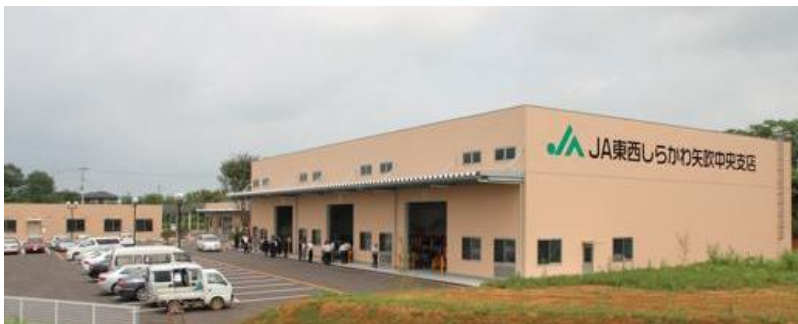
完成した矢吹中央支店の外観(手前右が低温管理ができる共同農業倉庫)
