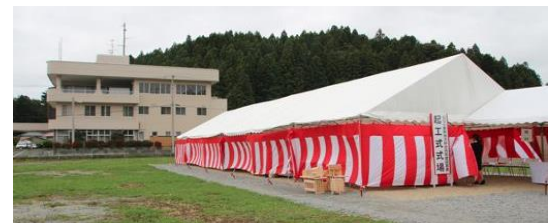
警察署と並んで建設される小野町病院
