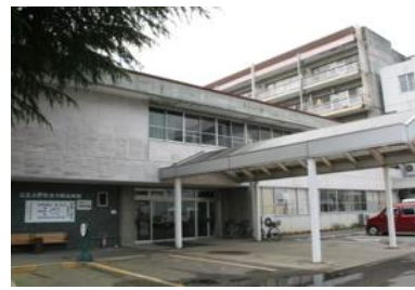
(亀裂が入った旧小野町地方総合病院)
