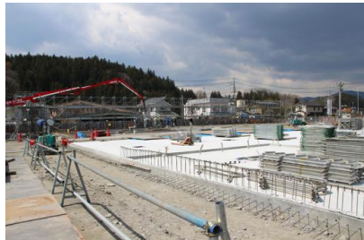
(建設の様子、2014年4月)
