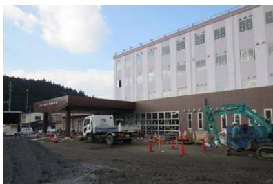
(完成間近の小野町病院)
